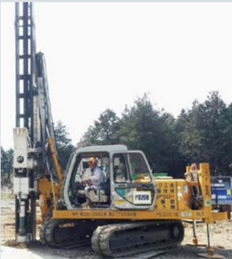
クローラー式杭打ち機
