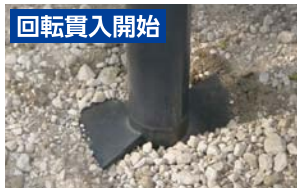
回転貫入状況
