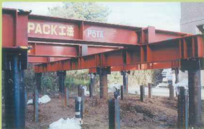
歪ゲージ装着試験杭 (NPバック・ハイバック) 施工風景
