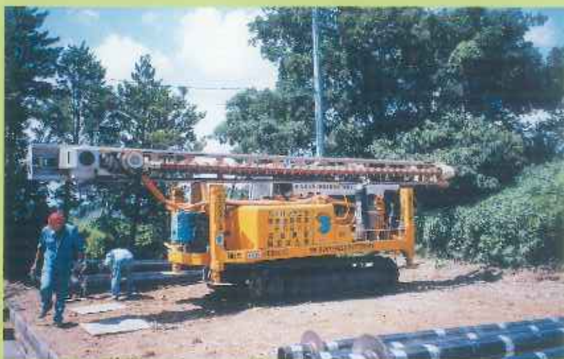
歪ゲージ装着試験杭 (NPバック・ハイバック) 施工風景
