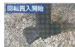
回転貫入状況
