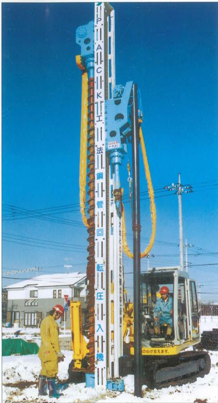
鋼管杭圧入施工 (PACK工法)
